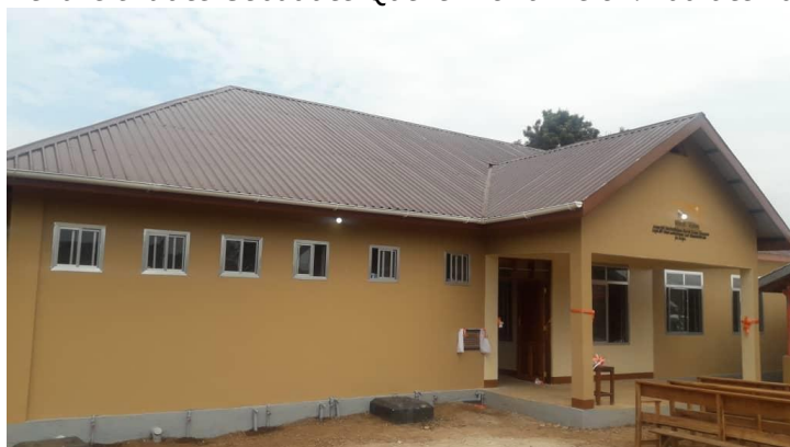
Quelle World Vision: Frontansicht des Gebäudes
